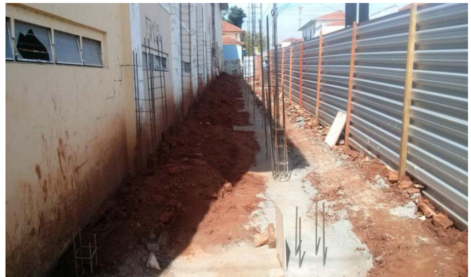
Continuação das obras de reforma do Salão Paroquial – Rampa e Escada da Entrada principal, pela Rua Floriano Simões – Outubro 2016
