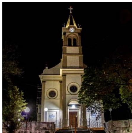
Fachada principal – Junho de 2022
