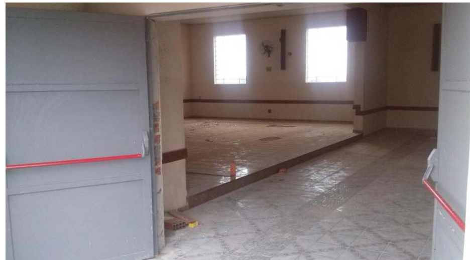
Entrada principal do Salão Paroquial com trave de saída de emergência
