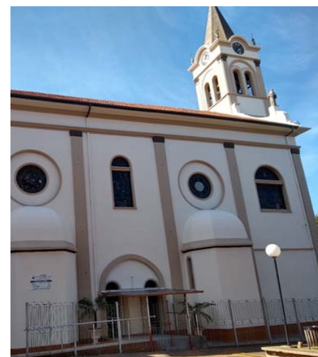
Pintura Externa da Matriz Lateral da Praça - Junho 2022
