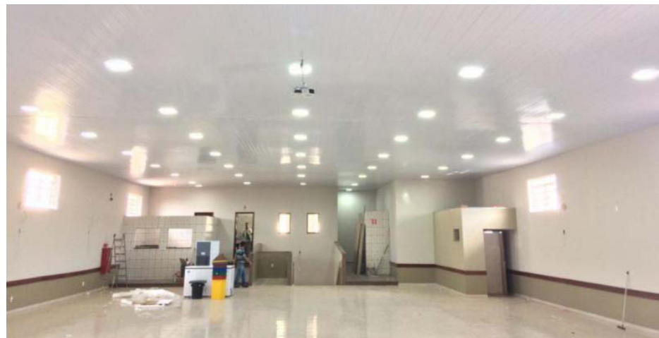
Salão Paroquial – Reforma concluída - Cozinha reformada e Banheiros – Maio 2017
