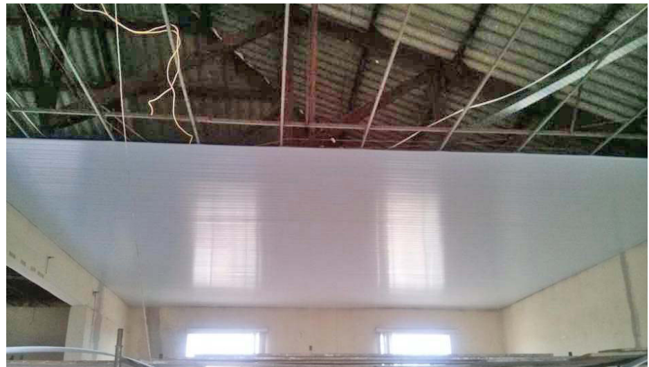
Início da colocação do forro novo - Abril de 2017
