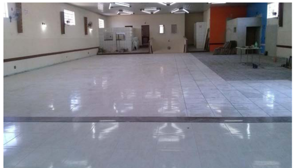
Colocação do piso novo – 450 m – Fevereiro 2017
