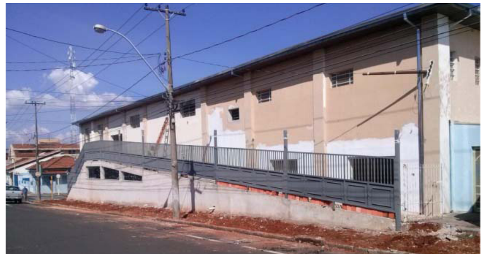
Grade pronta para a cobertura de vidro e início da construção da calçada e da pintura externa – Fevereiro 2017
